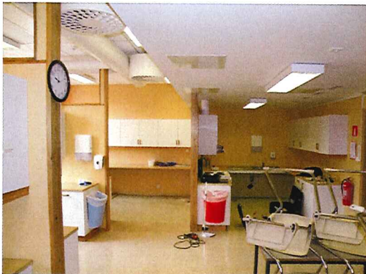
Foto 1. Skolekjøkkenet. Området hvor det har vært en lekkasje fra oppvaskmaskinen er rett fra (den omtalte lille delevveggen midt i bildet).
