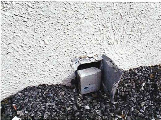
Foto 3. Utvendig luke inn i gulvkonstruksjonen under skolekjøkkenet og naturfag. Luftanalyser tatt inn i luken.
