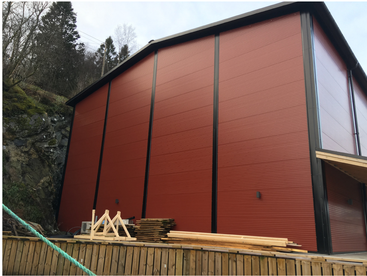
FOTO 1. Ny verkstedhall med fjellskråning og FV245 mot vest.
