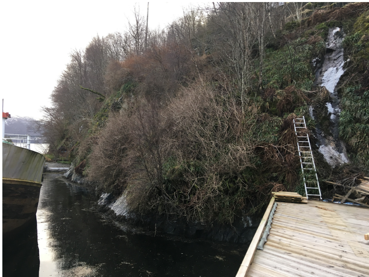
FOTO 4. Friluftsområde sett mot sør med FV245 på oversiden av området.
