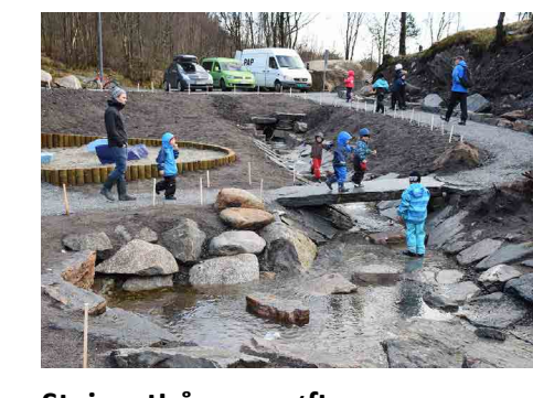
Steinsatt åpen grøft
