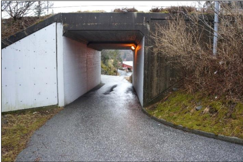
Figur 5.1.6 Kulvert nyttast i dag som både g/s-veg og biltilkomst til eigedomar. Høgda er 3,6 meter, høgda bør vere min. 4 meter.
