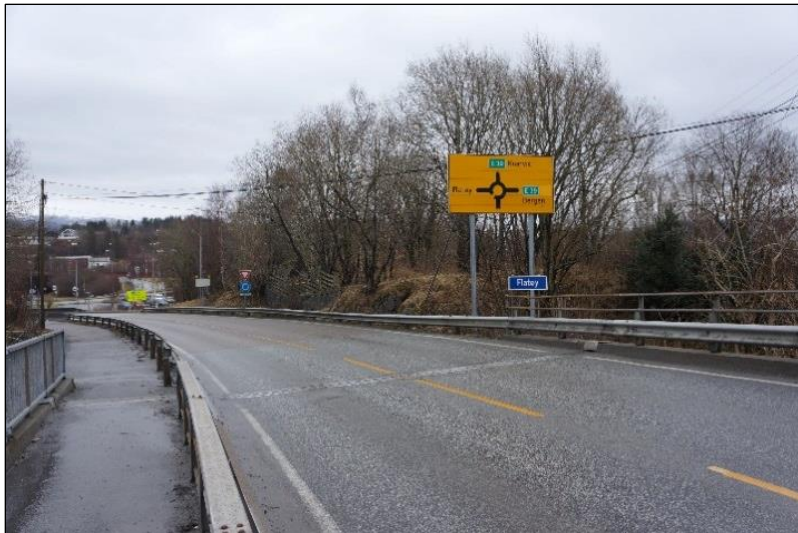
Figur 5.1.11 Fv.564 frå brua mot rundkøyring, i nordleg retning.
