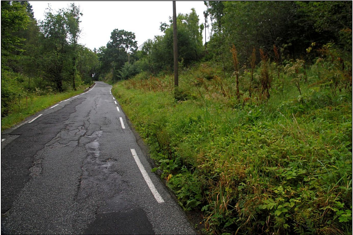
Fig. 22. Nord i sone 3 går den tette skogen over i eldre kulturmark og skogkanter, nå en naturtype i gjengroing, men ennå med en del tradisjonelle kulturmarksarter. 8. august 2016. Foto: A. Håland.
