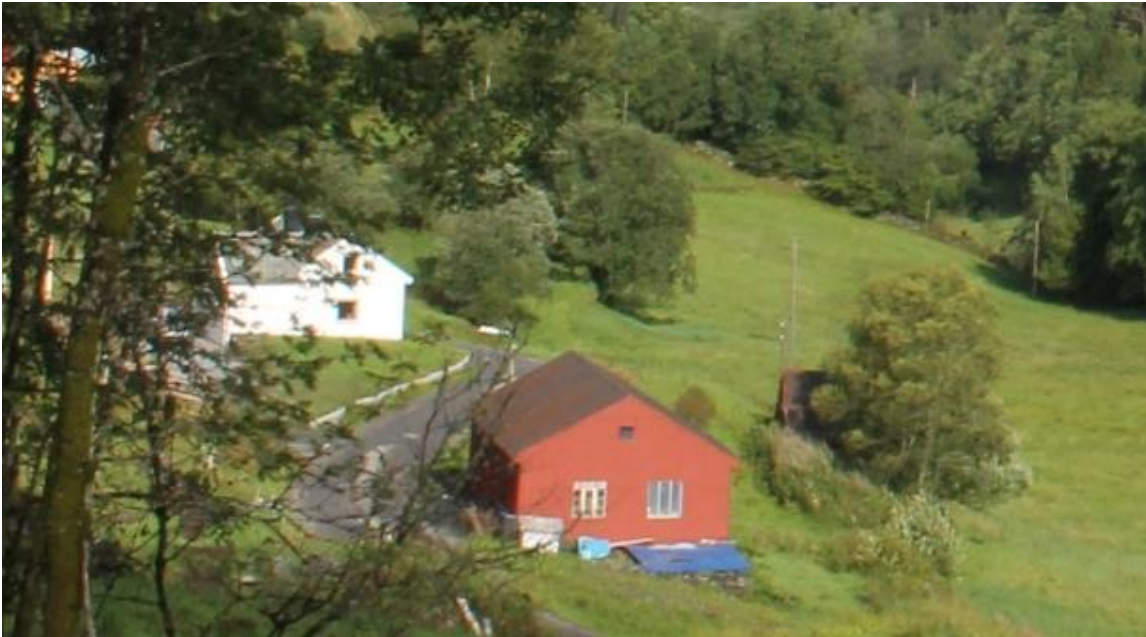
Figur 29 Gnr 30 bnr 1 gnr 30 bnr 1. Vegen vil leggjast om og gå mellom den raude løa og vedhuset.
