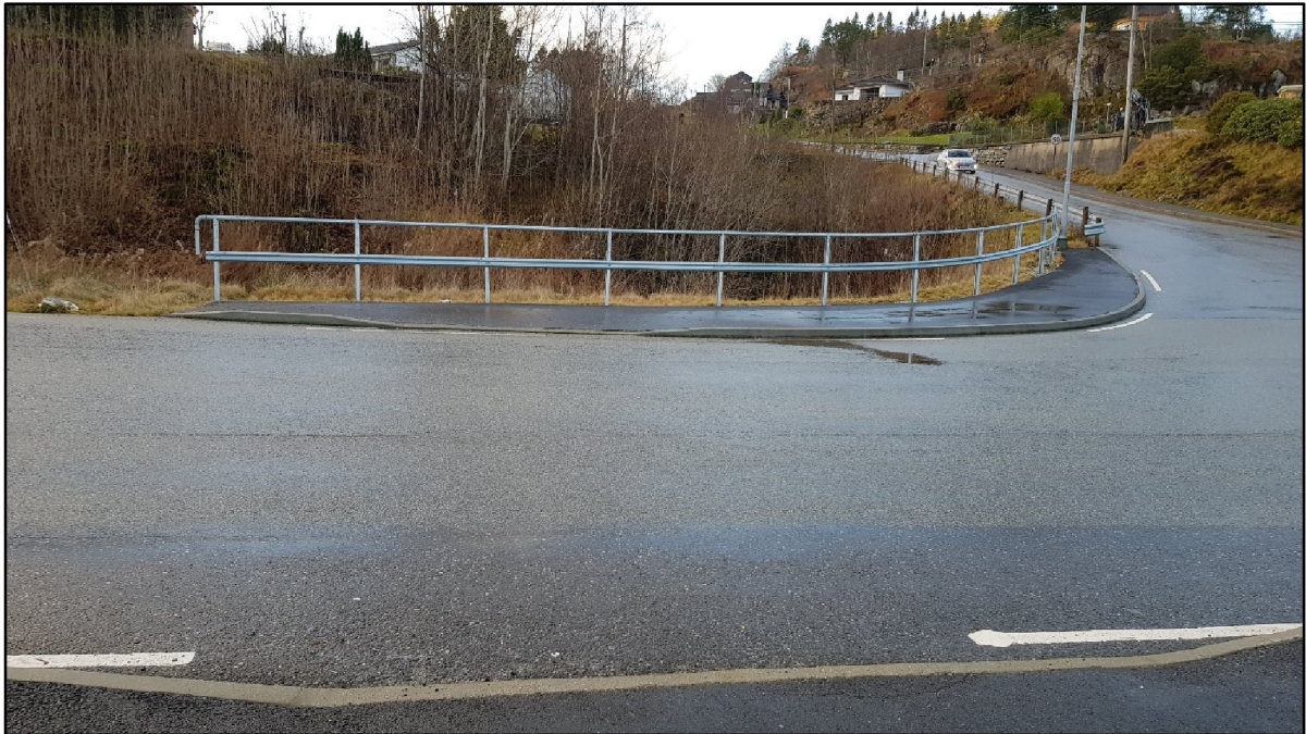
Figur 7: Fv.245 Ådlandsvegen i front, med kryssingspunkt med nedsenka kantstein. Den kommunale vegen Fosse opp til høyre i bilete. (Foto frå desember 2018)
