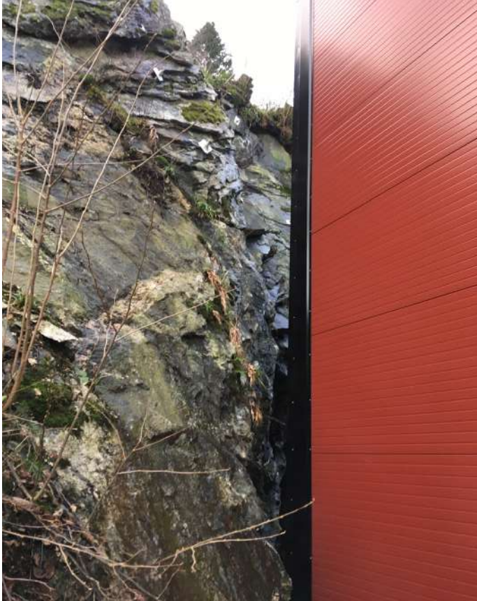
Figur 46: Foto av ny verkstedshall og fjellet FV 245 er fundamentert til.
