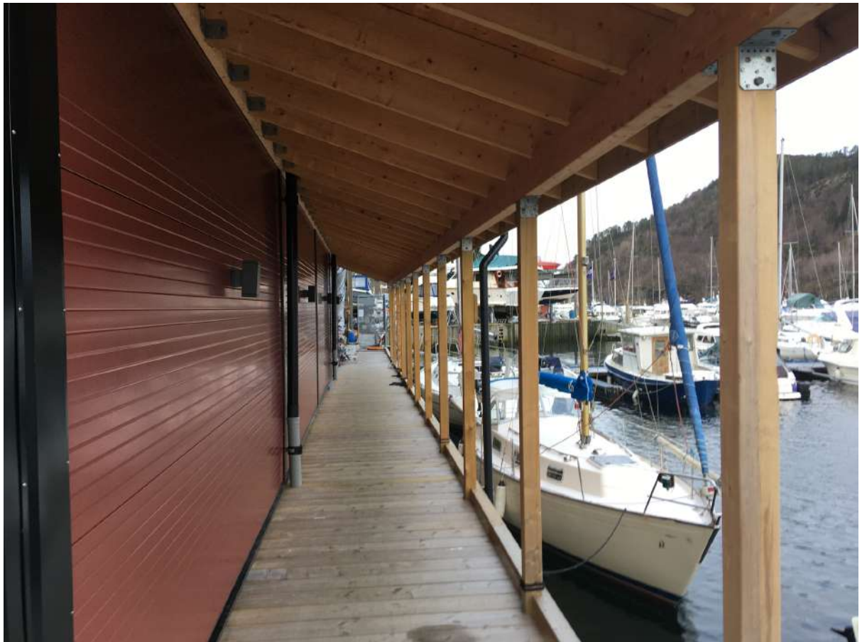
Figur 44: Passasje med overbygd tak som leder til friområdet og flytebrygger.
