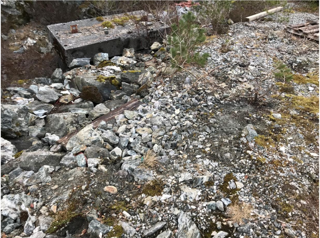
Oversikt bilde av eiendom om plassen hvor takplater var plassert:
