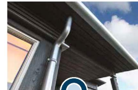
Nedløp for vann Integrert i takkonstruksjonen.
