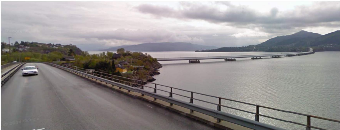
Figur 27. Nordhordlandsbrua, med Flatøy til venstre. Bilete er teke frå Krossnessundbrua (foto: Google streetview).
