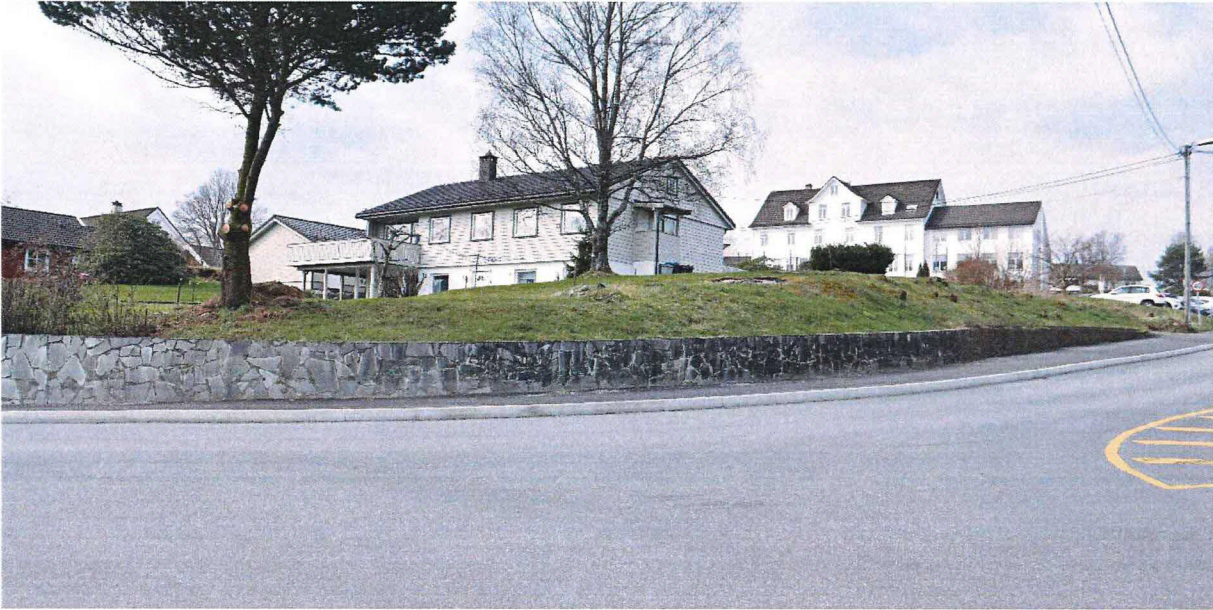
Nåv. situasjon , sett mot SYD . Gulvnivå i overetasjen blir ca. 0,3m. lavere enn det bestående hus.
