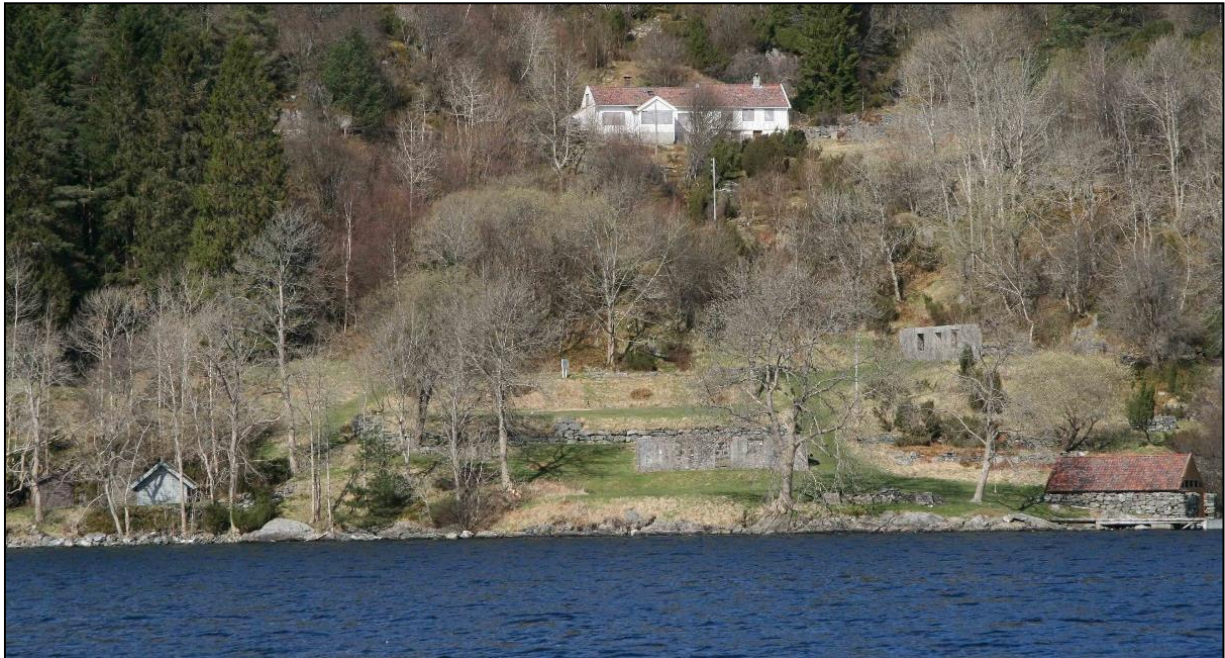
Figur 9 Oppsynsmannsbustaden, tidlegare gardsbruk, på Håøya, sett frå Flatøyosen, som er del av militæranlegget som vart bygd opp før og under 1. verdskrig. Bergen og Omland Friluftsråd forvaltar i dag området
