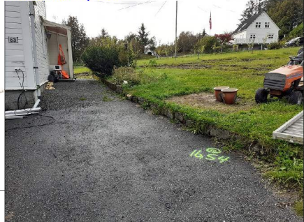
Høydereferanse merka på asfalt med asfalt spiker
