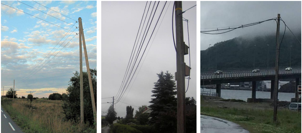
Eksempel på anlegg som vil omfattast av endringar i luftfartshinderforskrifta: lågspentlinjer, gatelys og midlertidige anlegg.
