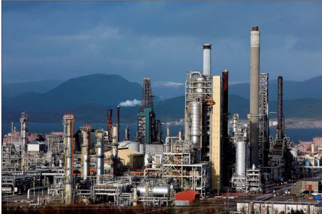
Oljeraffineriet på Mongstad er det største i Norge. I tilknytning til raffineriet fins eit avansert testsenter for karbonfangst og lagring (TCM). Bilete: Bergens Tidende.
