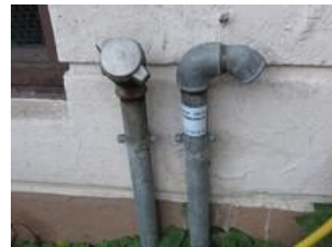
Feiermester i samtale, og lufter- og påfyllingsrør på ein oljetank.
