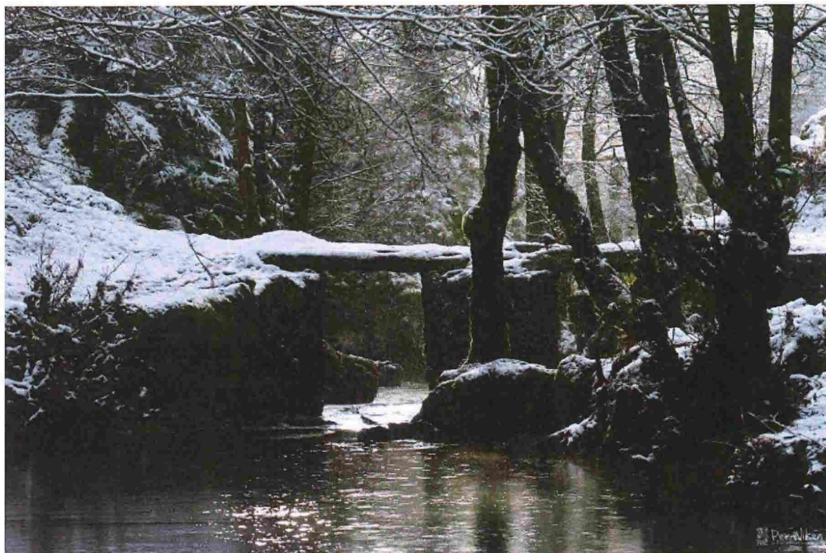
Bru over Mjåtveitelva - «Brune»
