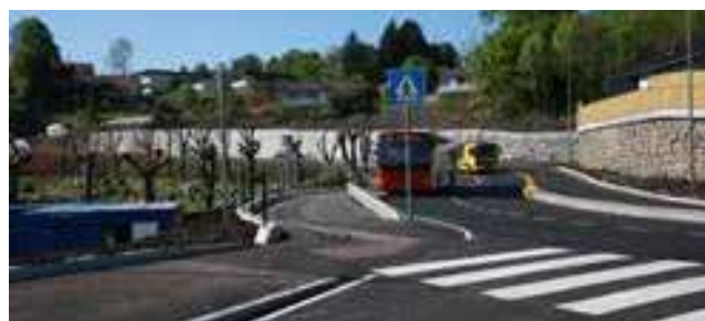
Kollektivfelt Foto: Statens vegvesen
