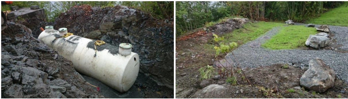
Prosjekt 653 Slamavskiljar Orrhøyen I. Gjenbruk av slamavskiljar frå Havnehagen (prosjekt 659)
