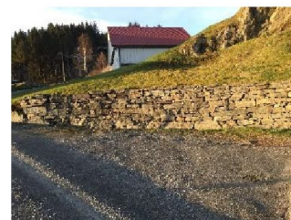
Eksisterende avkjørsel privat vei
