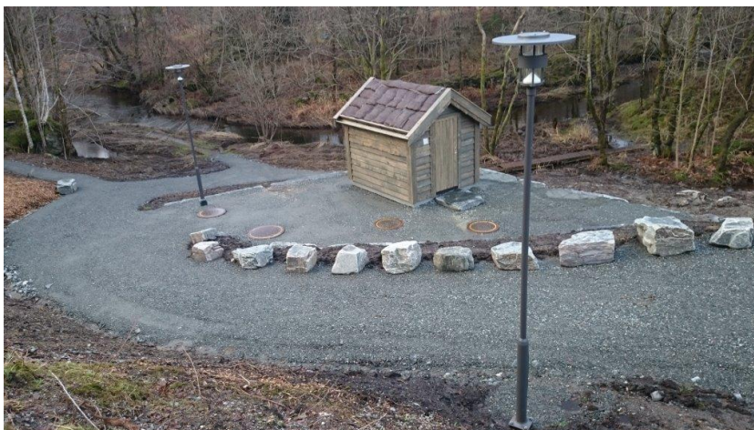
Prosjekt 605 – Oppgradering pumpestasjon Mjåtveit
