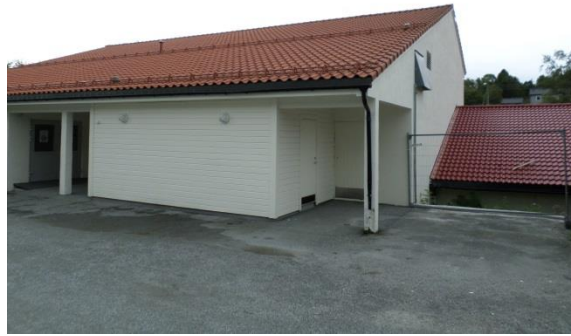
Prosjekt 762: Nytt tak og maling på Symjehallen på Rosslund skule
