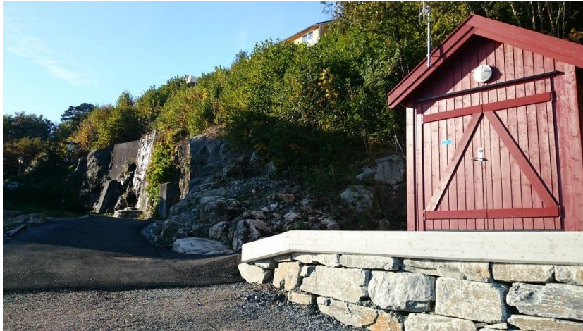
Prosjekt 639 Sanering Markavegen - Ny pumpestasjon ved Havnehagen
