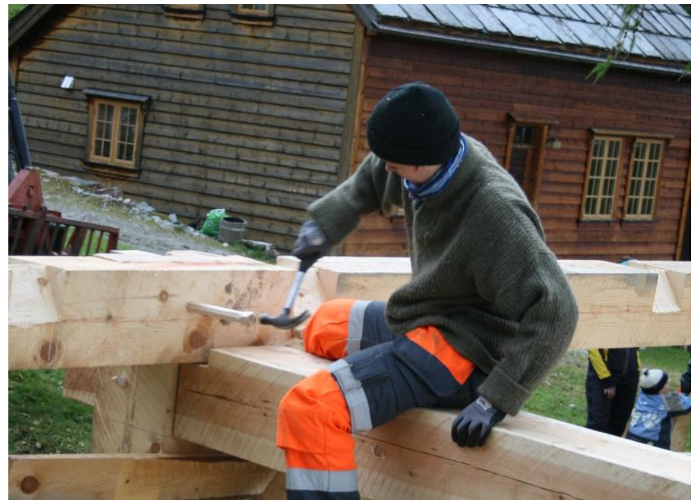
Grinder og takstolar på plass (over). Det vert nytta trenagle i staden for spikar (under).
