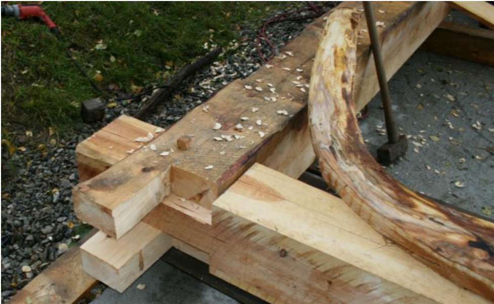
Samansetjing av grind med trenaglar (over). Tillaging av emne til snedband (under).
