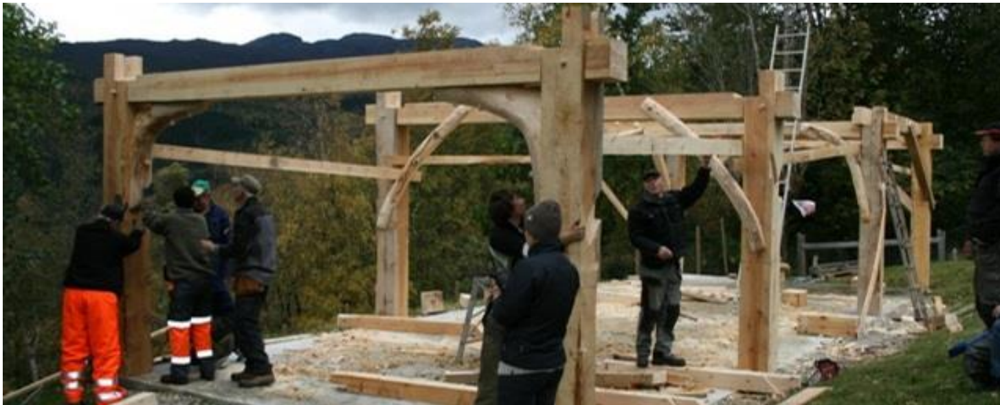
Under: Reising av grindar på grindbygget. Over: Sjur og Johan jr. legg torv på taket.
