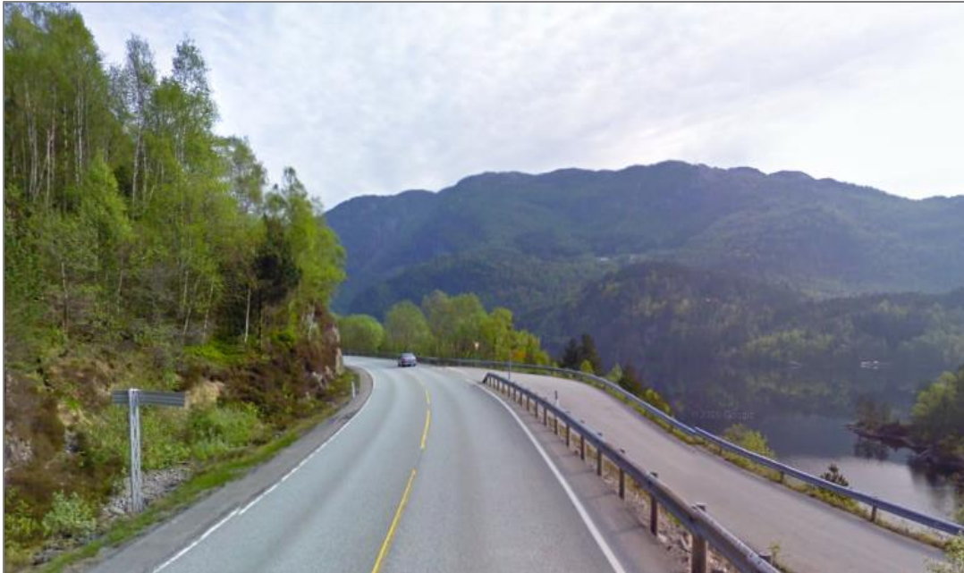
Figur 23: E 39 - Molvikkrysset, mange kryss langs E 39 er ukanaliserte og har dårleg sikt, slik som dette.
