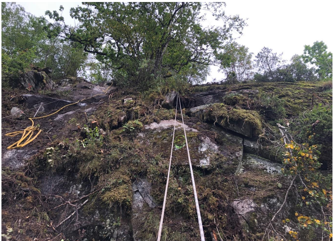
Bilde 4. Nedre del av skredløp med flere sprekkeavløste blokker og flak. Blokkene sikres med bolter eller spettrenskes ned.
