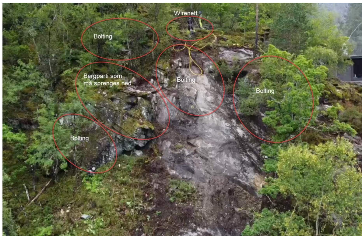
Bilde 1. Oversiktsbilde fra drone med aktuelle sikringstiltak i øvre del av skredløpet.
