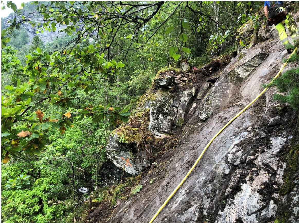
Bilde 3. Ustabilt bergparti som må sprenges ned.
