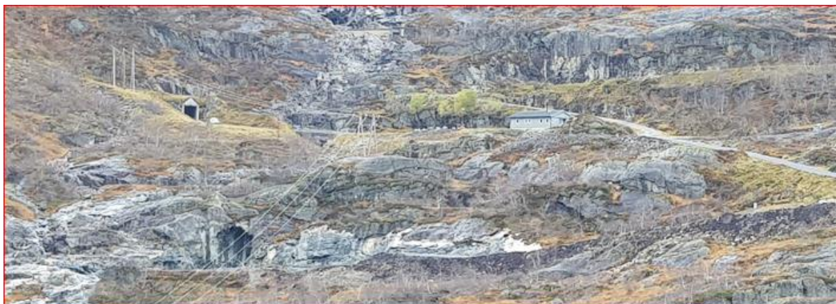
Figur 2 På foto viser portalbygget til Åsebotn kraftstasjon (oppe til venstre). Midt på bilde ligg Eviny si driftshytte (grå hytte). Nedst i bilde ser vi utløpet av ny overløpstunnel (flomtunnel) frå Stølsvatnet
