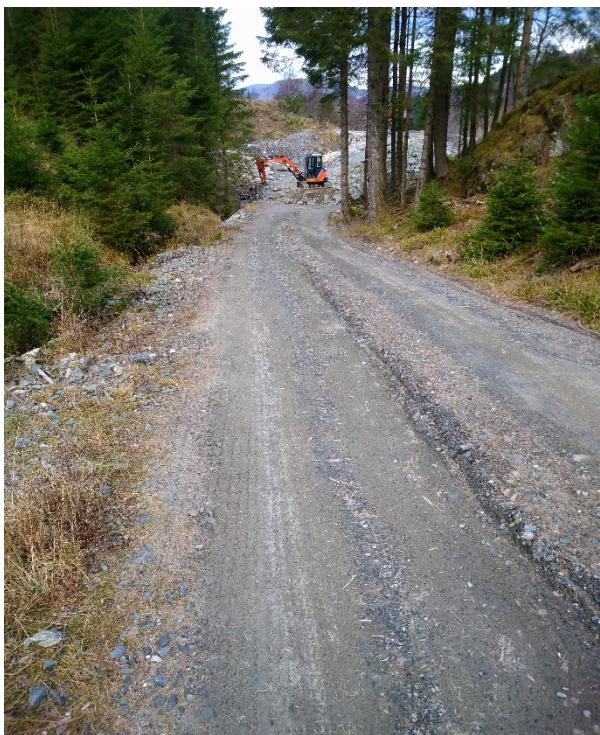
På venstre side av vegen går den omtalte bekken fram mot fyllinga. Det går av søknaden fram at planen no er å legge røyr gjennom vegen i framkant av gravemaskina. Bekken skal då leggast om slik at den renn rundt fyllinga/snuplassen.
