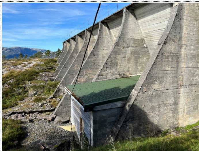
Dam med lukehus
