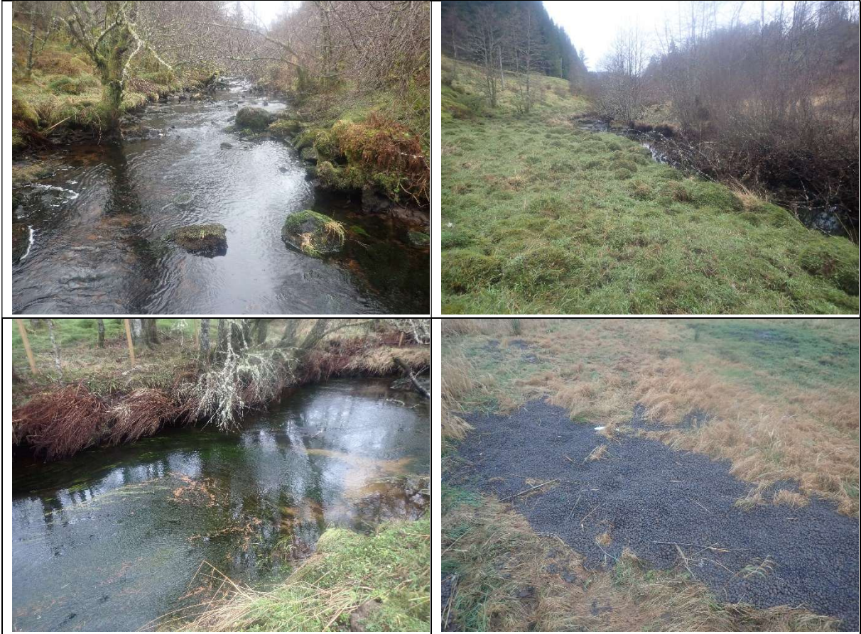
Figur 8. Nederste del av bekken fremstår som en flott og variert strykstrekning (oppe til venstre). Oppstrøms første veikryssing er det et beiteområde der bekken er noe gjengrodd av vannvegetasjon og her anbefales noe opprensning. Nede til høyre: Lecakuler som ligger igjen etter forrige flom.
