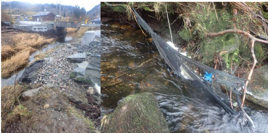
Figur 6. Arbeid med nytt krysningspunkt over elva ved Valestrandsveien og eksempel på forsøpling i elva som bør ryddes opp.
