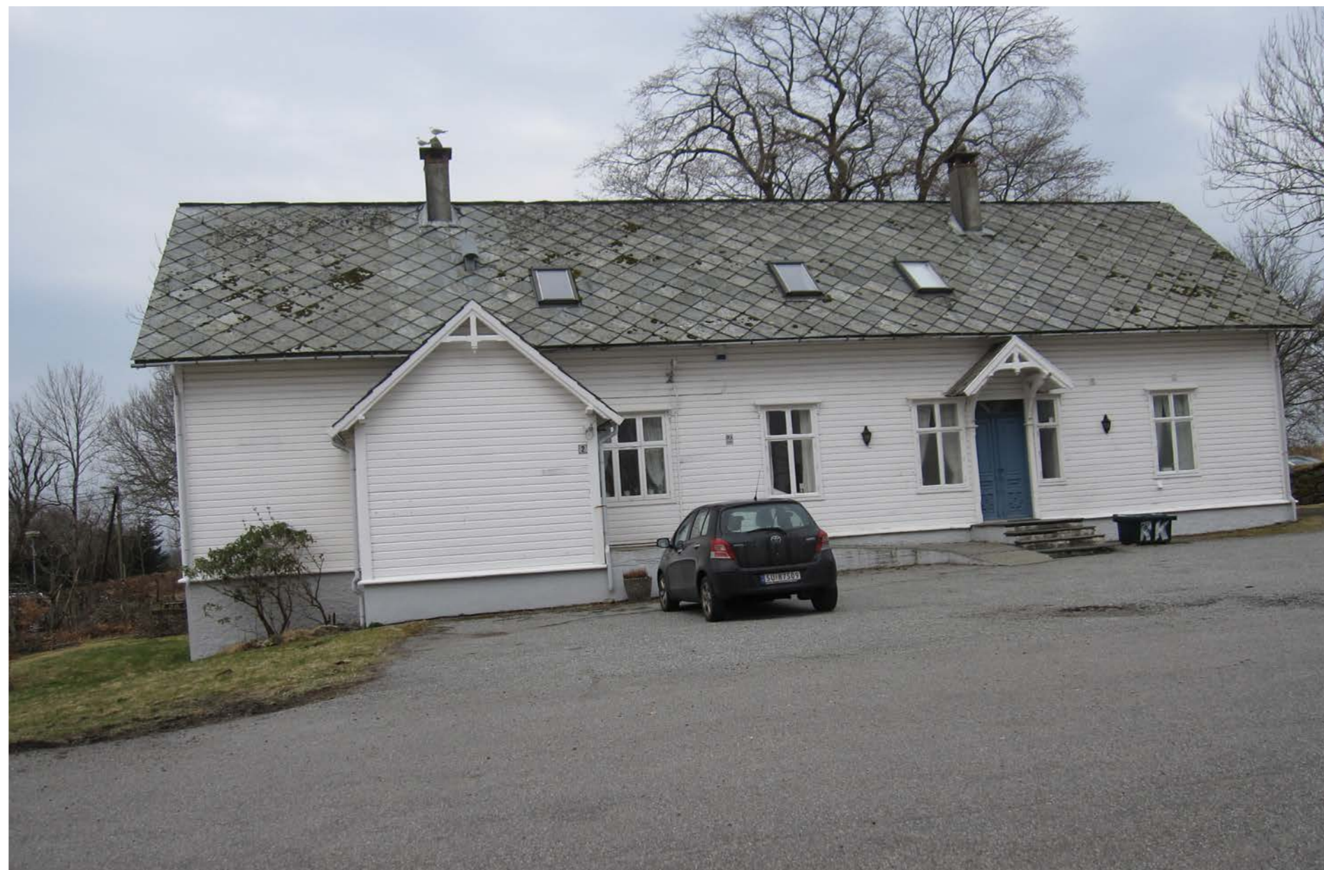
Fremsiden av Prestegarden, sett mot sør.
