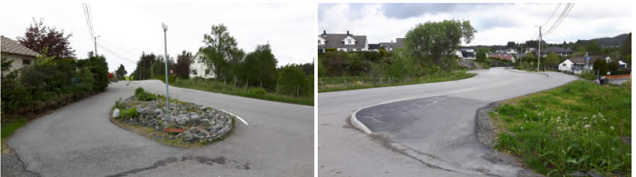
Figur 9 Siktilhøva i krysset
