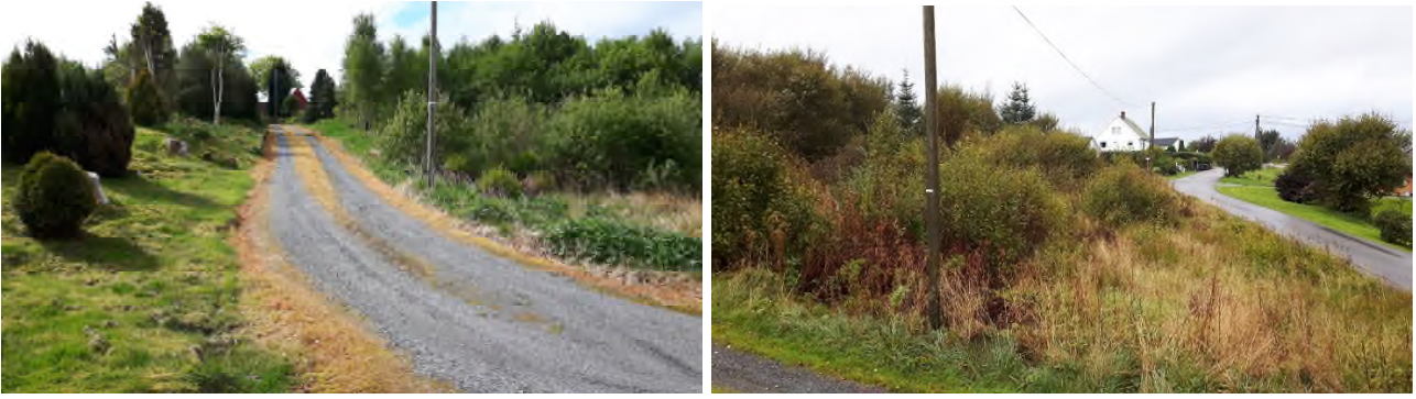
Figur 12 Avkøyrsløse inn i sjølvne planområdet (Urhaugvegen i bakgrunn til høgre på siste bilete).
