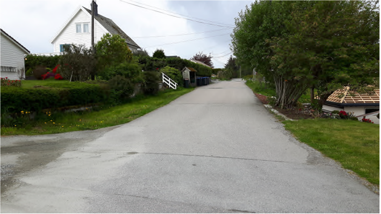
Figur 10 Første del av kommunal veg, Urhaugvegen, sett mot fylkesvegen
