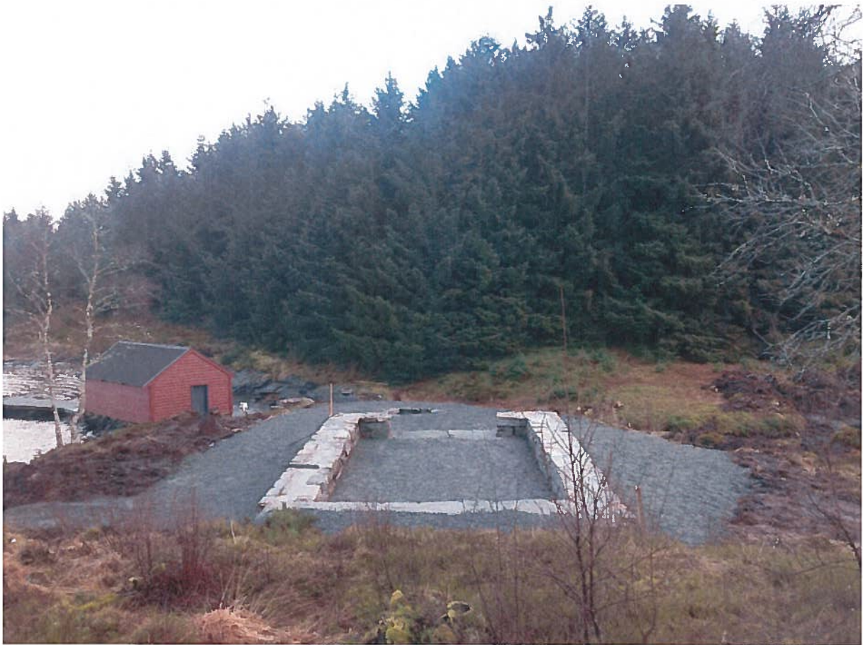
Bilde 4: Grunnmuren til grillhuset.
