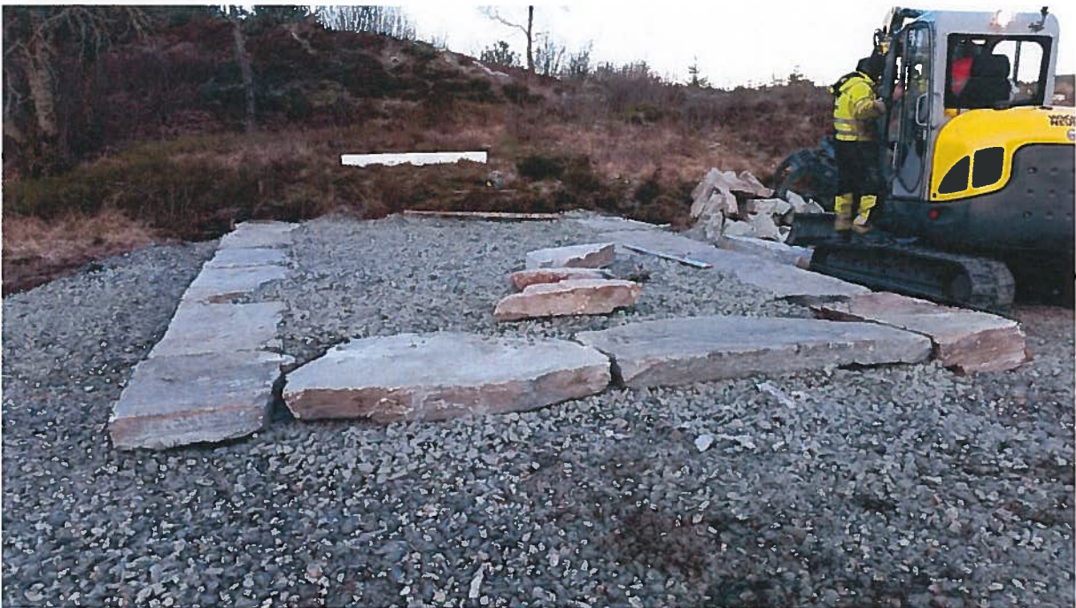
Bilde 2: Muring av platen til grillhuset.
