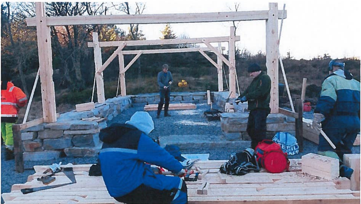
Bilde 5: Oppsetting av grillhuset.
