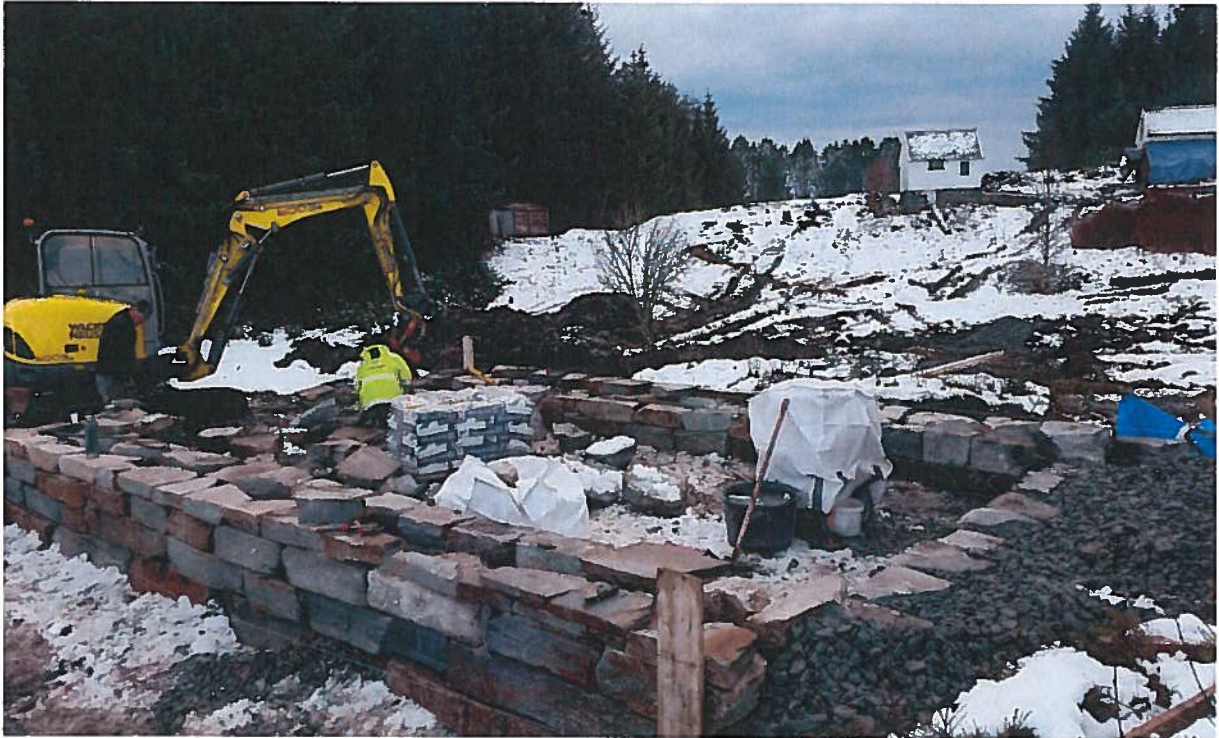
Bilde 3: Bygging av grillhuset.
