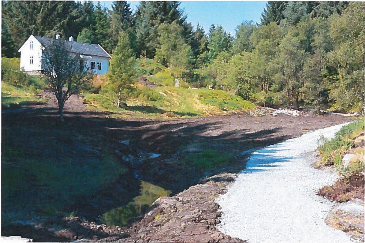
Bilde 1: Ferdig opparbeidet flerbruksflate i Skageneset friluftsområde.
