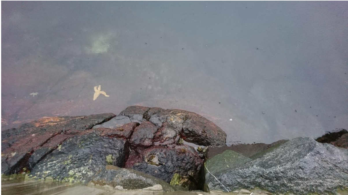
Bilde 2: Viser videre langs kaifront mot nordvest. Viser enden av fjell i strandlinje.
