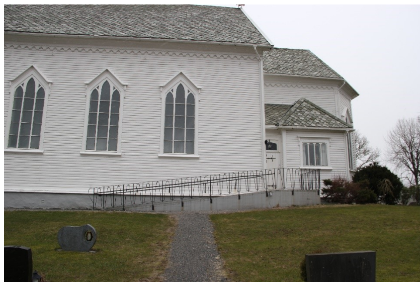
Manger kirke, dør til prestesakristi sett fra sørvest (mars 2017) Biskopen i Bjørgvin ønsker at denne rampen erstattes av trapp
