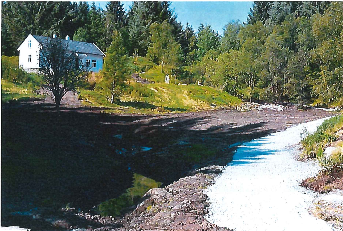
Bilde 1: Ferdig opparbeidet flerbruksflate i Skageneset friluftsområde.
