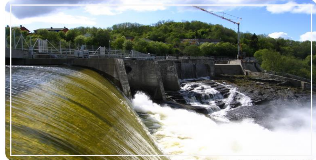
Øvre Leirfoss Kraftverk. Foto: Jo H. Halleraker
