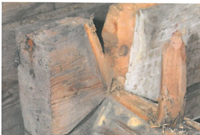
Figur 10 Eksempel på dømling i lafteverk
