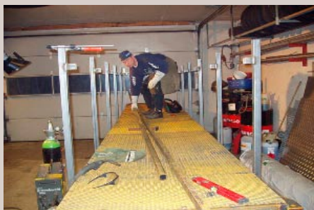
Rampe av stål under arbeid.
