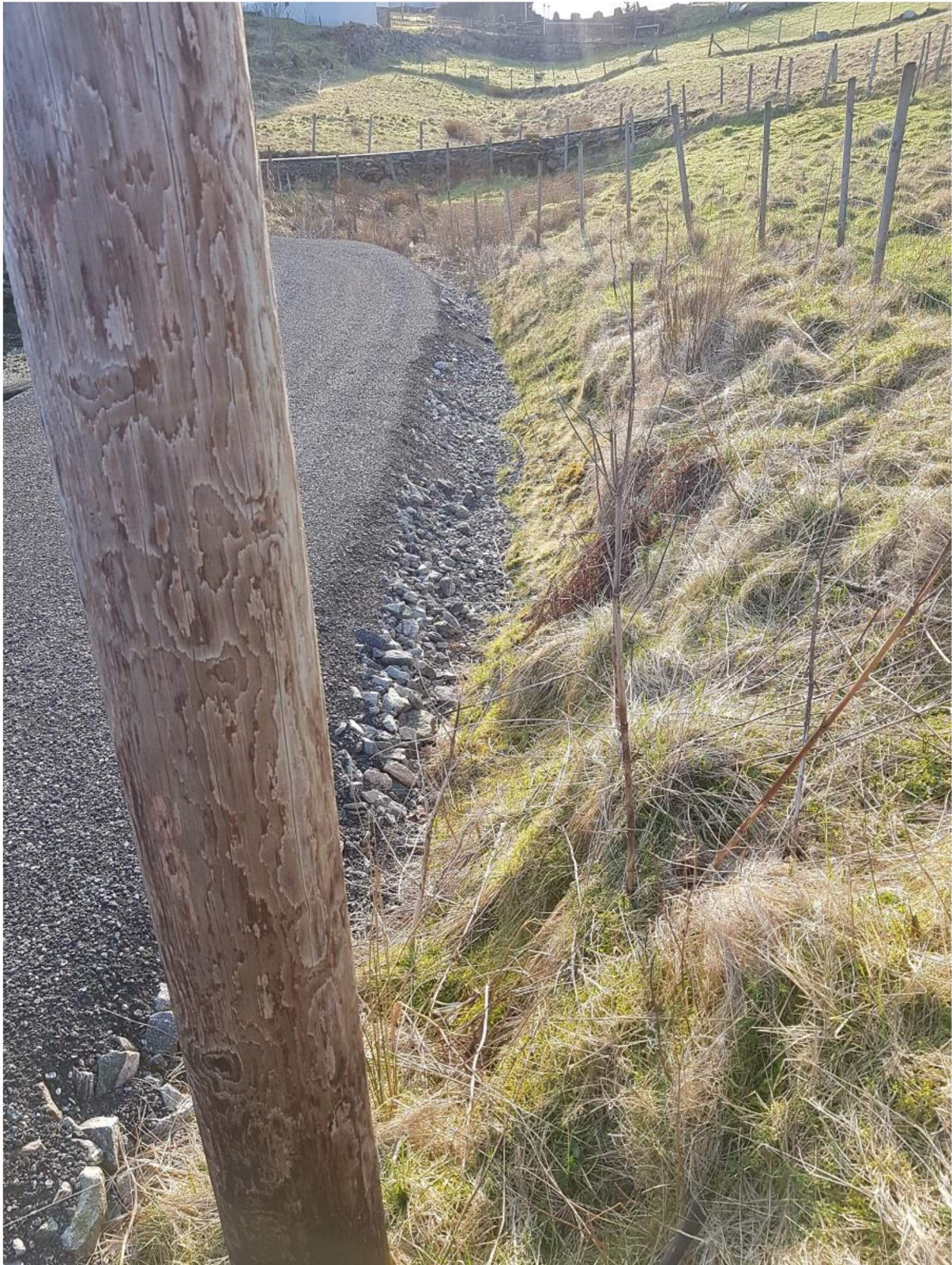
Figur 6 Grøft etter vedlikehold
