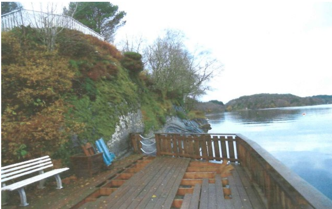
Foto: Schinnes Byggentrepnør AS 2012
