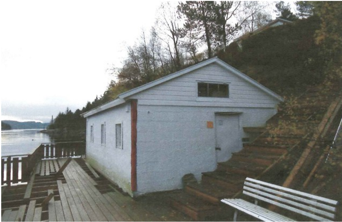
Foto: Schinnes Byggentrepnør AS 2012
