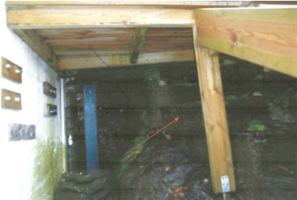
Foto: Schinnes Byggetreprenør AS 2012
