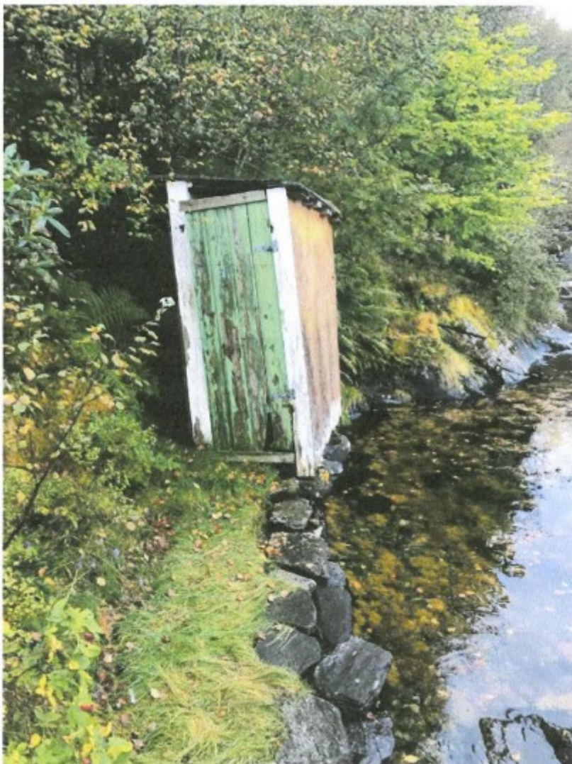
Figur 33: Bilde som viser dagens toalettløsning. Det er en enkel bøttedo. Som man ser vil vannstand ved høyvann nærmest gå inn i do.
