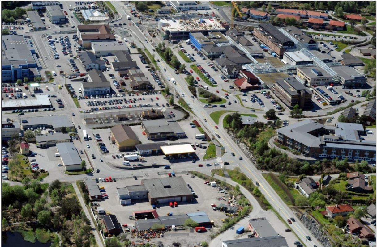
Skråfoto frå aust viser tydeleg dagens byggestruktur og arealbruk.
