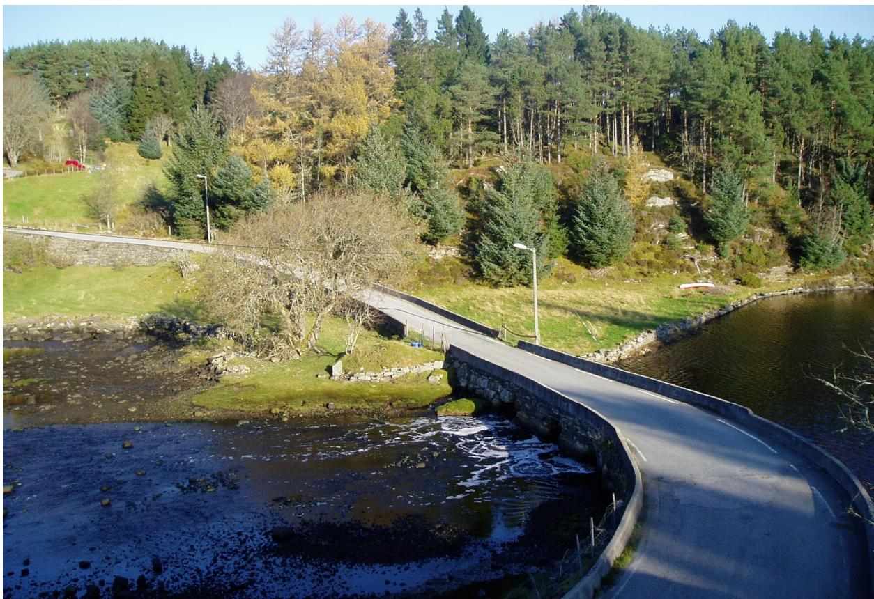
Landbruksavkjørslene frå fylkesveg 409 til bruk nr. 5 aust for kryssinga av Villangervågen er ikkje lenger brukande på grunn av heva vegdekke og støypt rekkverk på sørsida.
