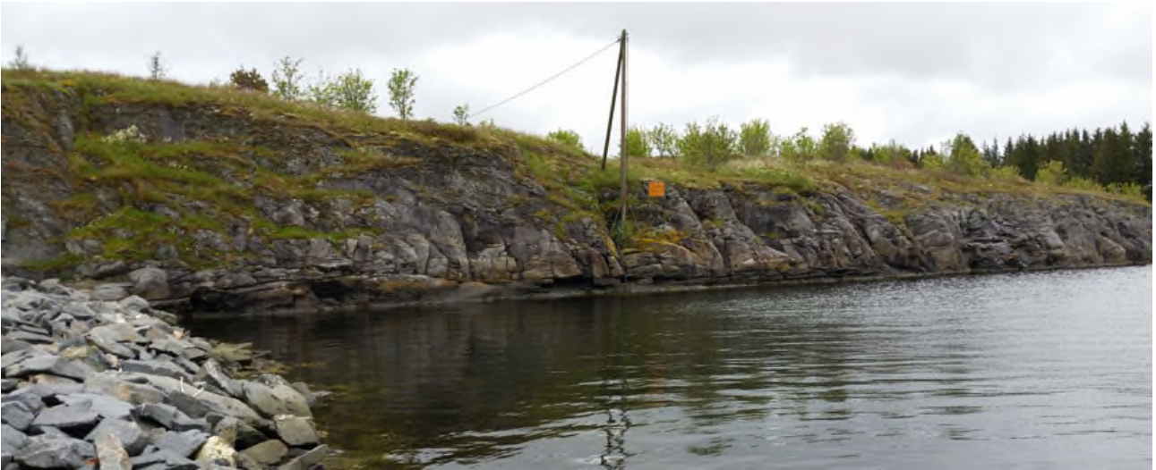
Figur 8 Sørøstleg del med sprengsteinsfylling og bratt strandlinje
