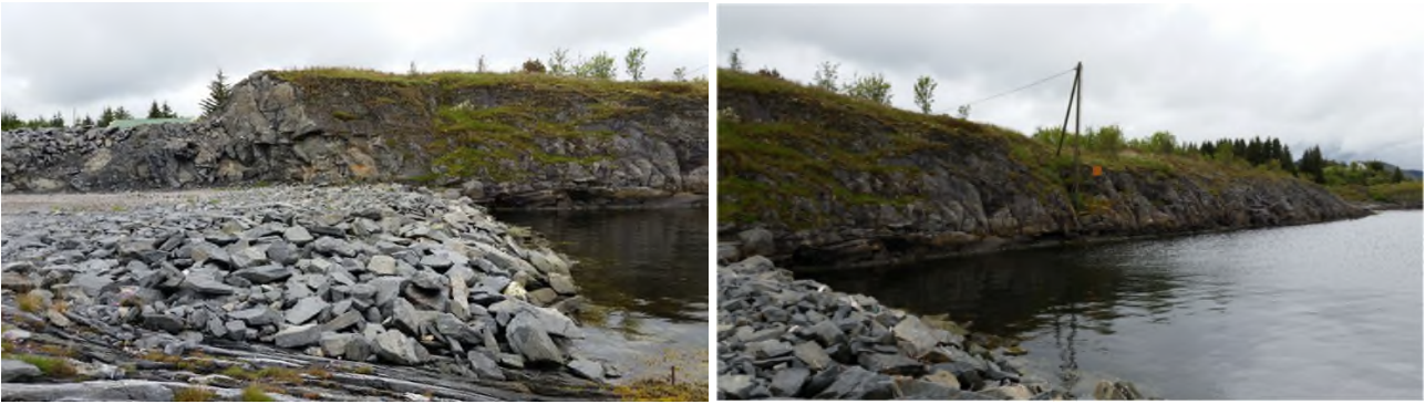
Terreng aust i planområdet, (steinfylling og sjølinja aust for kaien, sett frå sør)
