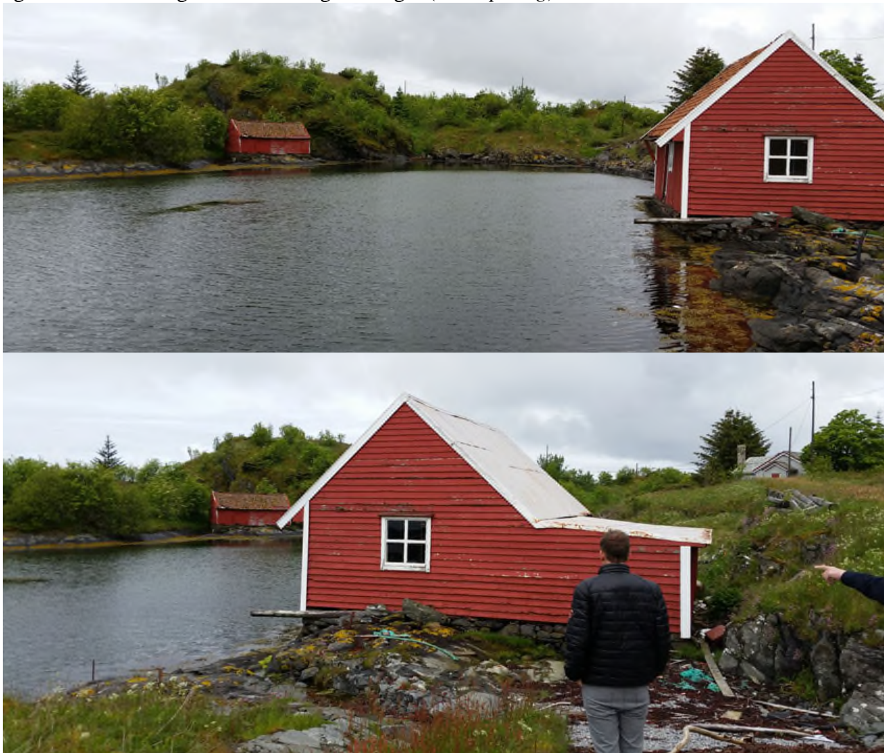
Figur 25 Naust til høgre i bilete og SEFRAK-registrert naust til venstre i bakgrunnen
