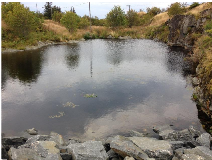
Figur 3-11 Dam inne på industriområdet
