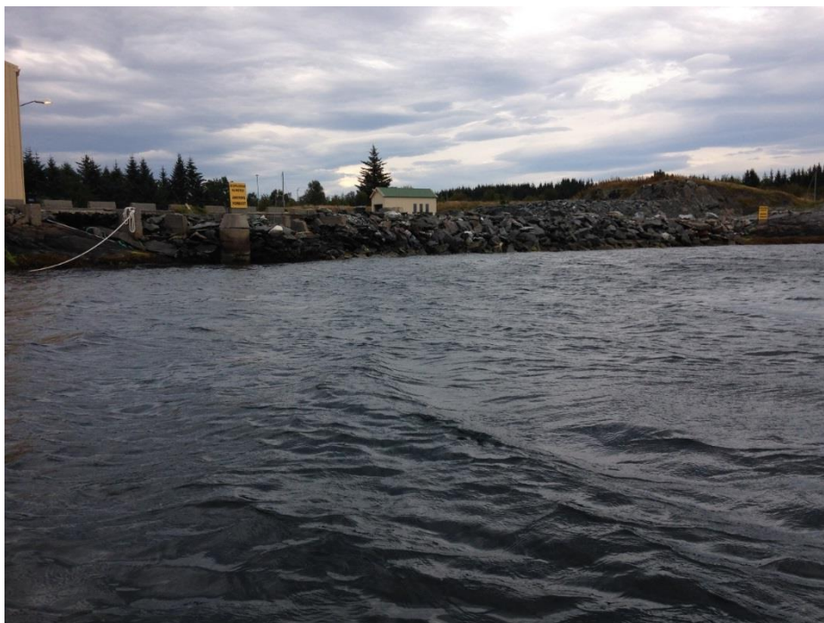
Figur 3-8 Eksisterende kai front sett fra sjøen
