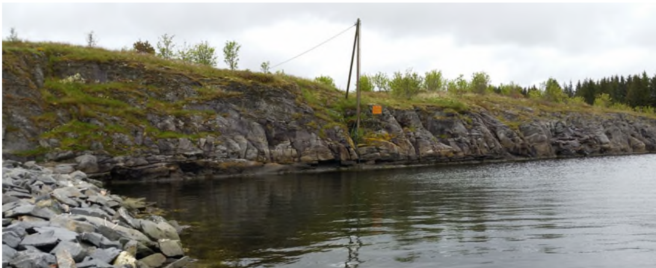
Figur 8 Sørøstleg del med sprengsteinsfylling og bratt strandlinje
