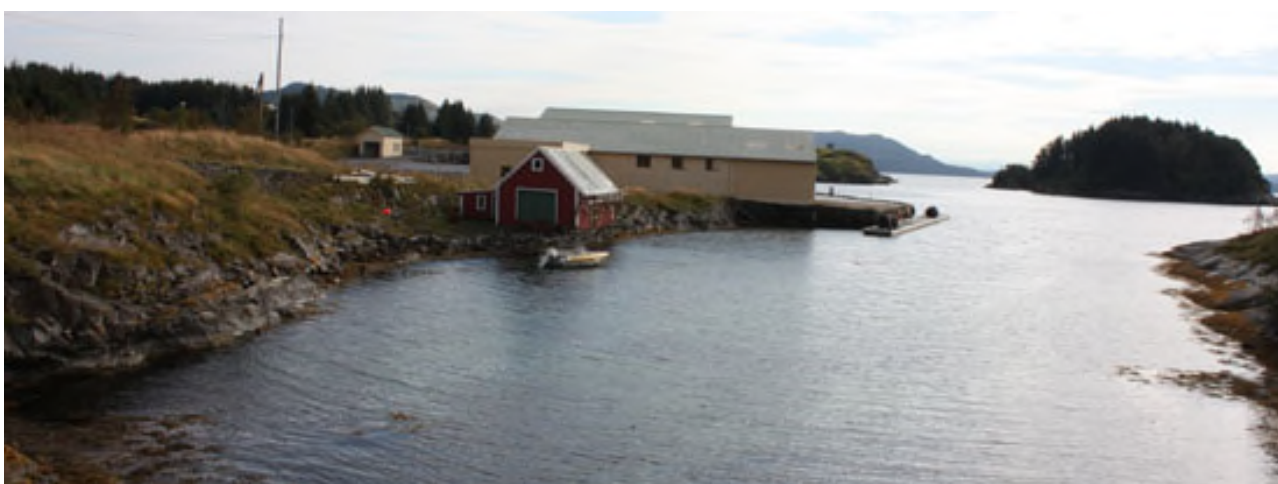
Figur 9 Sett inst frå vika mot eksisterande naust og bygg i planområdet.
