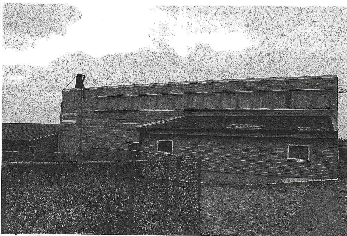
Kablar ut frå ventilasjonsrom og opp på tak. Kabling kan skjulast bak eit deksel lakkert i same farge som bygg
